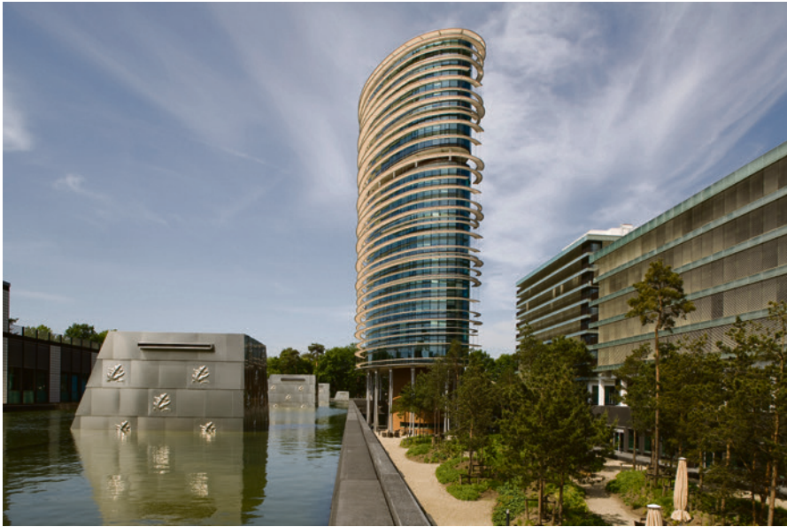
▲ Een groot retentiedak vinden op het Walter Bos complex in Apeldoorn. Hieronder ligt een parkeergarage.
