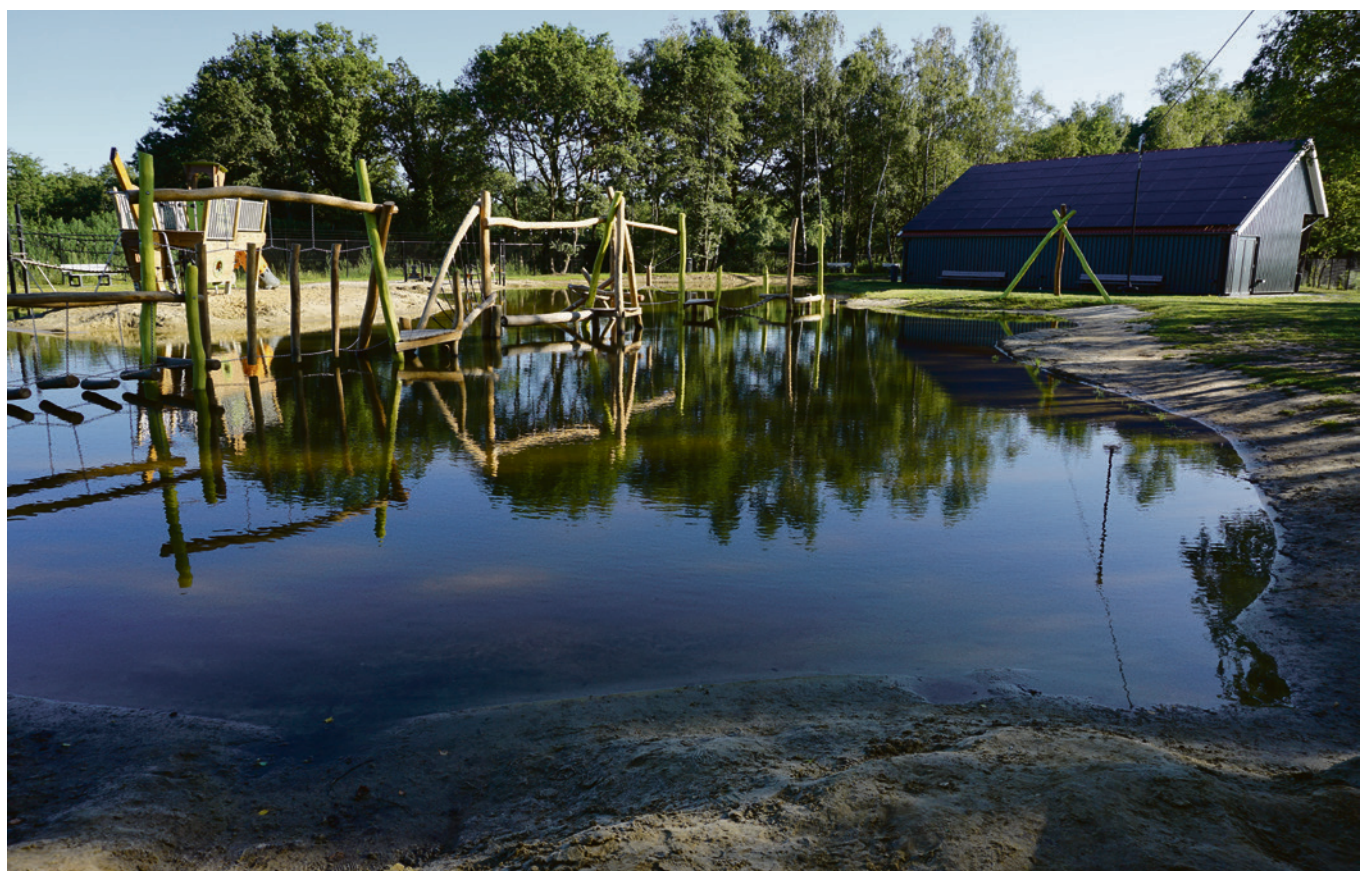
▲ Dit is een zogenoemde ‘Plonsplas’. Een recreatieve vijver met een waterdichting van EPDM en deels met zand afgedekt, waar kinderen veilig in kunnen spelen.
