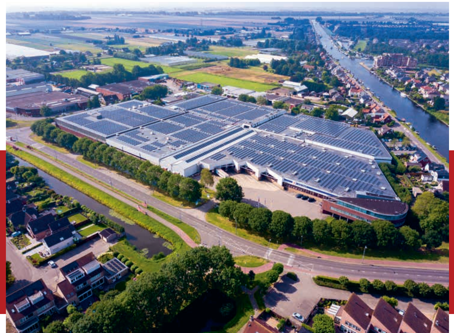
Van twee locaties van het Nederlandse bloembollenbedrijf Royal De Ree Holland in Lisserbroek is het dak gerenoveerd. In nog geen vier maanden tijd is in totaal 33.000 m 2 dakoppervlak geïsoleerd, bedekt met Firestone's RubberGard EPDM dakbedekking en voorzien van 11.000 m 2 zonnepanelen. (Foto: ©Royal De Ree Holland bv)
