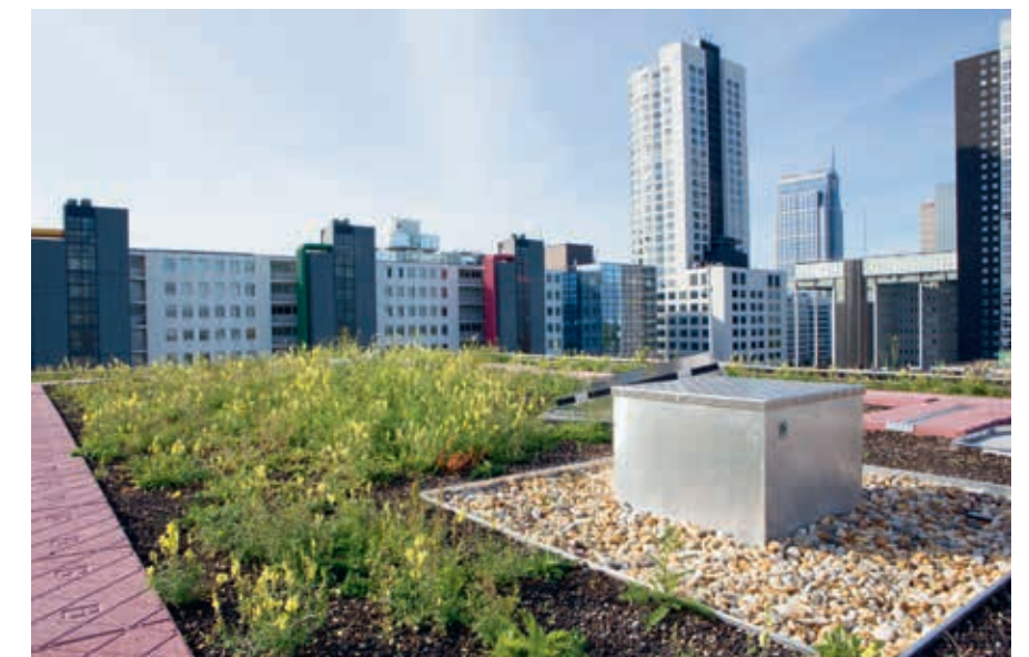
Slimdak-project op het Schieblock in Rotterdam: afgedicht met EPDM. Op één van de daken wordt het Smart Flow Control® systeem toegepast.
