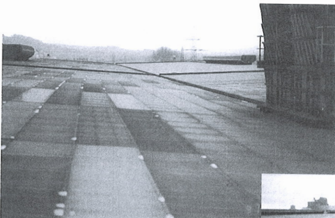
Het onder een zware gebruiksbelasting staande 60.000 m 2 grote EPDM-dak van de staalwalserij 'Dillinger Hüttenwerke'.
