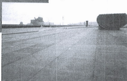
Het onder een zware gebruiksbelasting staande 60.000 m 2 grote EPDM-dak van de staalwalserij 'Dillinger Hüttenwerke'.
